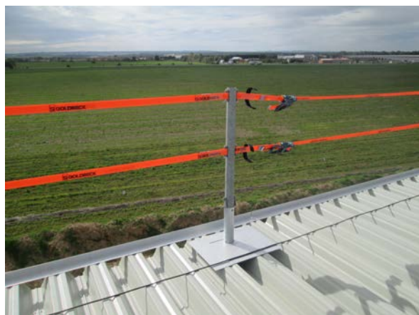
Příklady dočasných stavební konstrukce k ochraně volných okrajů
